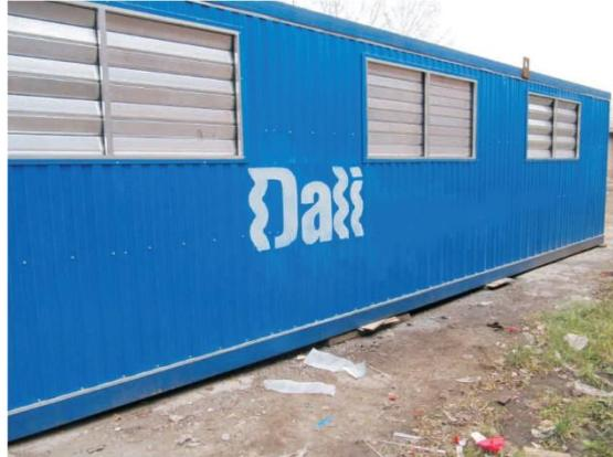
**Модульная компрессорная станция** (компрессорный блок контейнер) предназначена для снабжения сжатым воздухом различных устройств на железнодорожном транспорте, пневмосистем нефтяной, строительной, деревообрабатывающей, машиностроительной и других отраслях промышленности при температуре окружающего воздуха от -60 до +40 °С.
